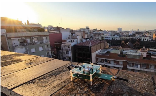
Einsatz des energieautonomen FOXES-Sensorsystems über den Dächern von Barcelona. Bild: Universidad de Barcelona
