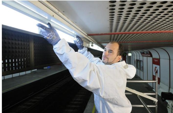
Sukzessive werden die Leuchtstoffröhren der Stationsbeleuchtungen durch moderne LED-Lampen ersetzt, die durch geringeren Stromverbrauch und lange Lebensdauer eine Ersparnis bewirken. CopyRight: Johannes Zinner
