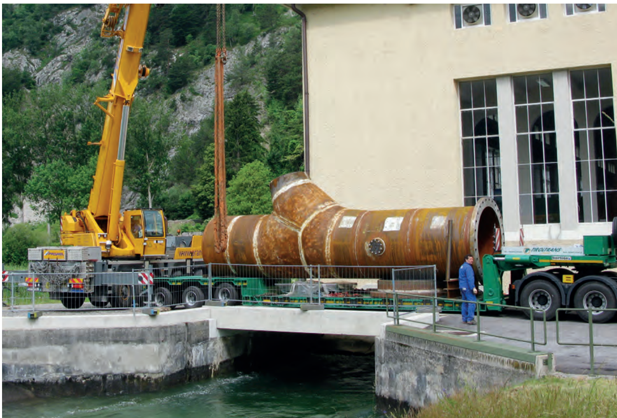
Einsatz von Grobblechen für Druckrohrleitungen im Kraftwerksbau (Quelle: Materials Center Leoben Forschung GmbH)
