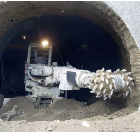
Eine Teilschnittmaschine beim Durchbruch einer Kammer (© Sandvik Mining and Construction)
